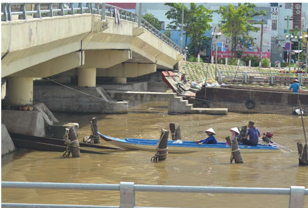
Ảnh 11: Hệ thống tời kéo – đường ray để kéo vỏ lãi qua cống.
